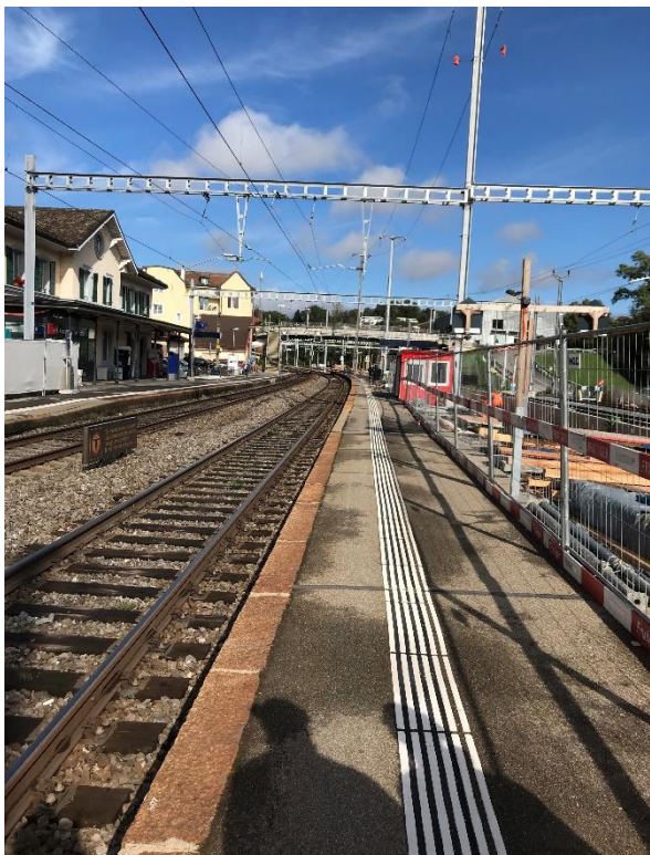
Vue du quai
