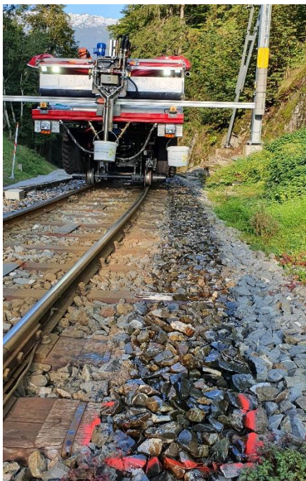
Vue du collage de ballast sur site
