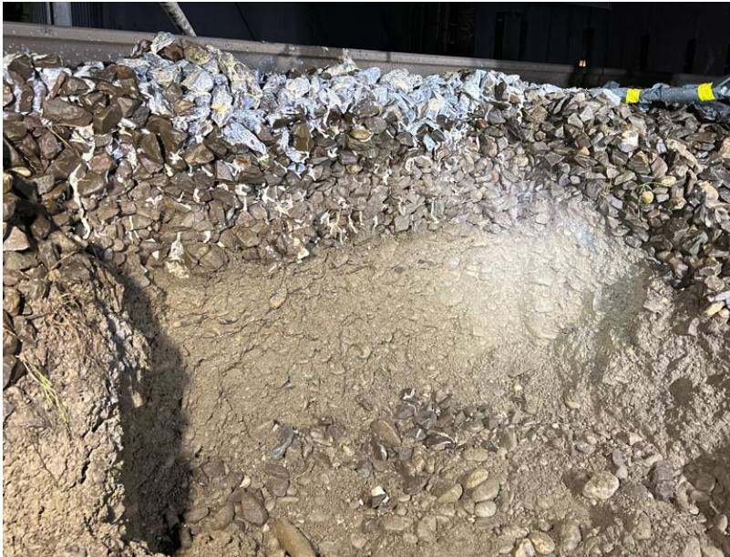
Ansicht auf die Verklebung
