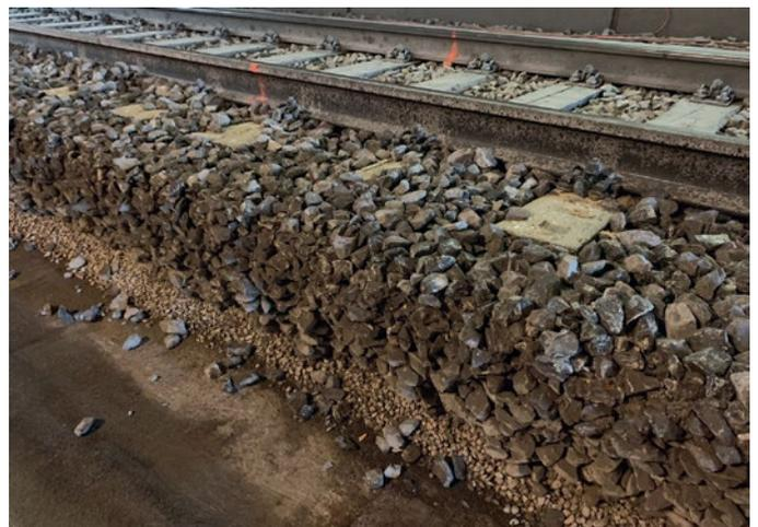
**6:** Vertikale Wand nach Verklebung mit Bahnbetrieb auf dem Bestandsgleis
