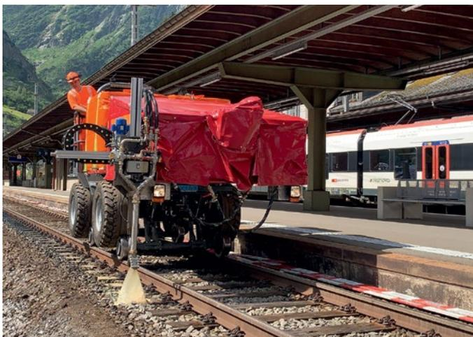
**5:** Schotterverklebung mit Spezialgerät im Einsatz
