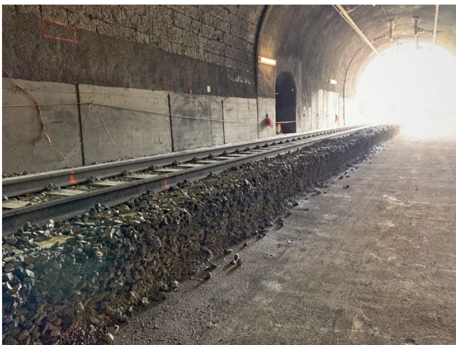
1: Beispiel einer ausgeführten Verklebung im Villnachertunnel
