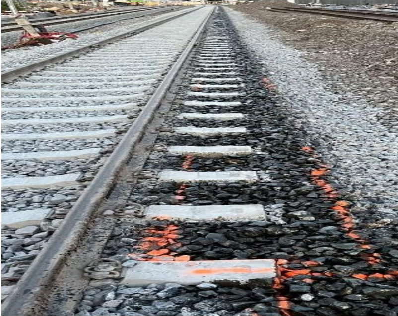
Ansicht auf die Verklebung nach der Applikation
