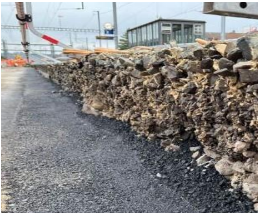
Ansicht auf die Verklebung nach der Applikation
