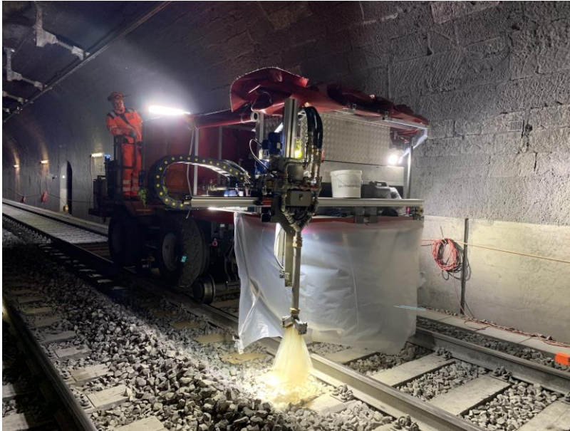
Ansicht auf Applikation im Tunnel
