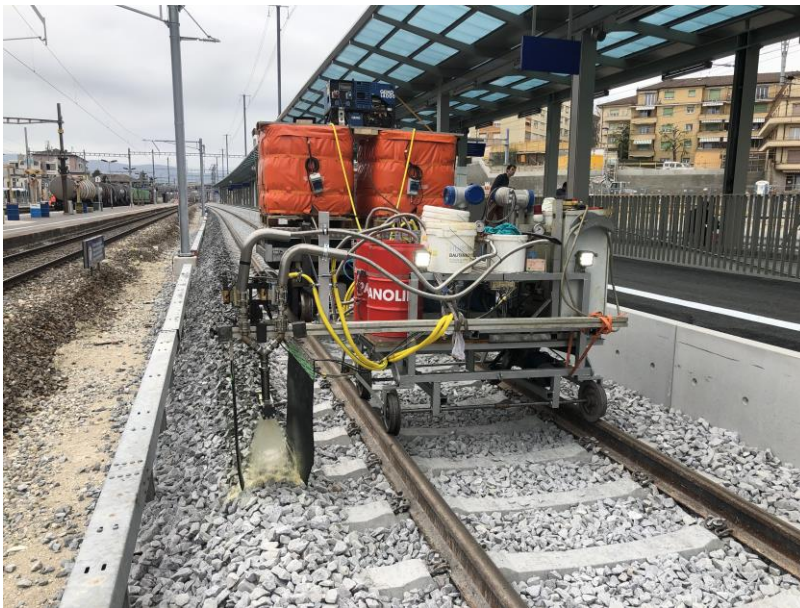
Ansicht auf erste Schotterverklebungsanlage der Hürlimann Railtec AG beim Applizieren
