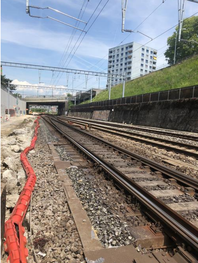
Ansicht Baustelle – links ist vor den Schwellenköpfen die Verklebung zu erkennen
