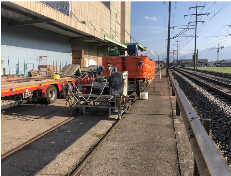
Ansicht auf die Schotterverklebungsanlage der Hürlimann-Railtec AG beim Eingleisen
