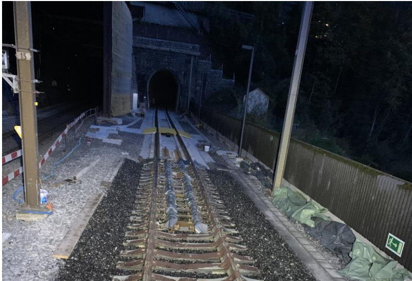
Ansicht auf die Schotterverklebung
