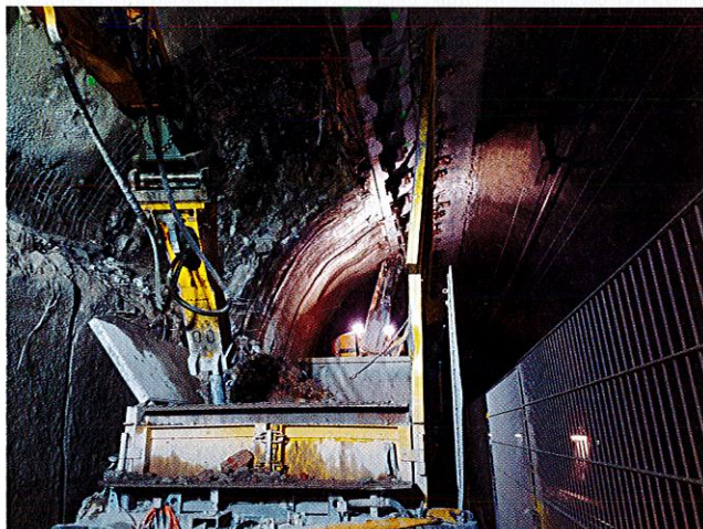
6 Ausbrucharbeiten unter engen Platzverhältnissen Excavation work under constricted space conditions
