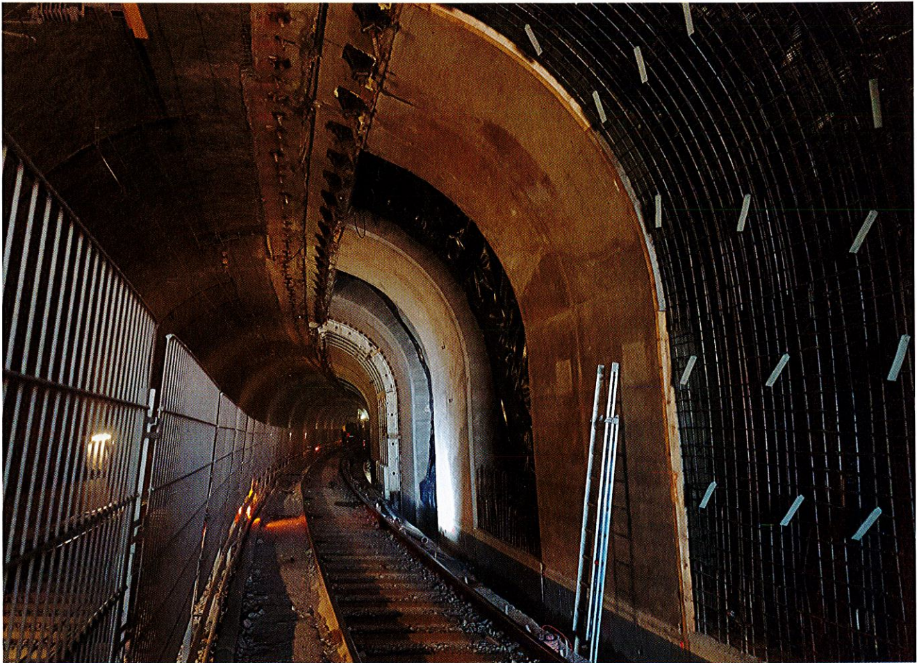
8 Betonieren im Schutze des Ankerriegels Concreting protected by the tie-beam
