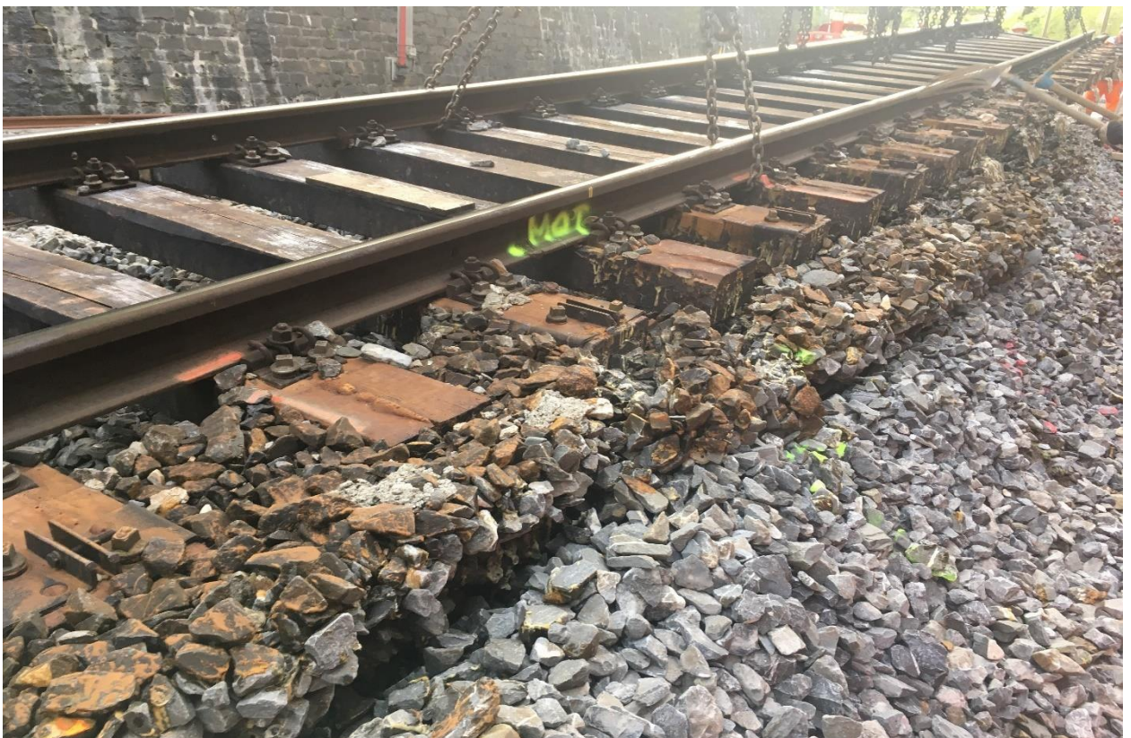
Abb. 5: Anheben eines Gleisjochs mit am rechten Schwellenkopf ausgebrachter Schotterverklebung (zwecks Sicherung Baugrube für vorgängig erstellte Fb-Entwässerung) ohne vorgängige Stopfung
